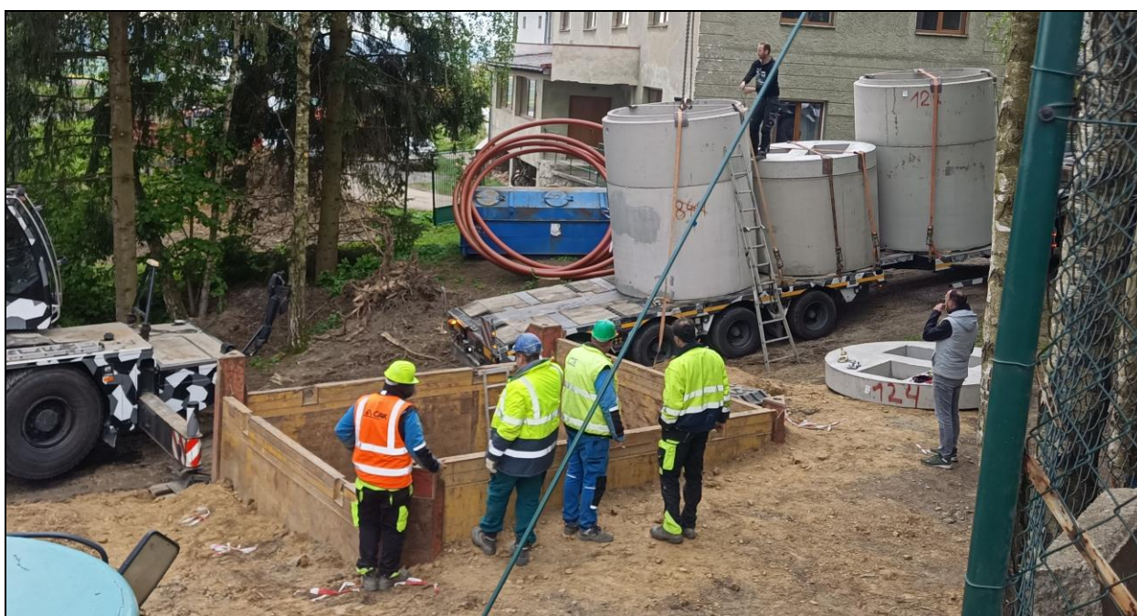
Výstavba splaškové kanalizace v Křivé, investorem Obec Dlouhá Loučka (duben 2024)
