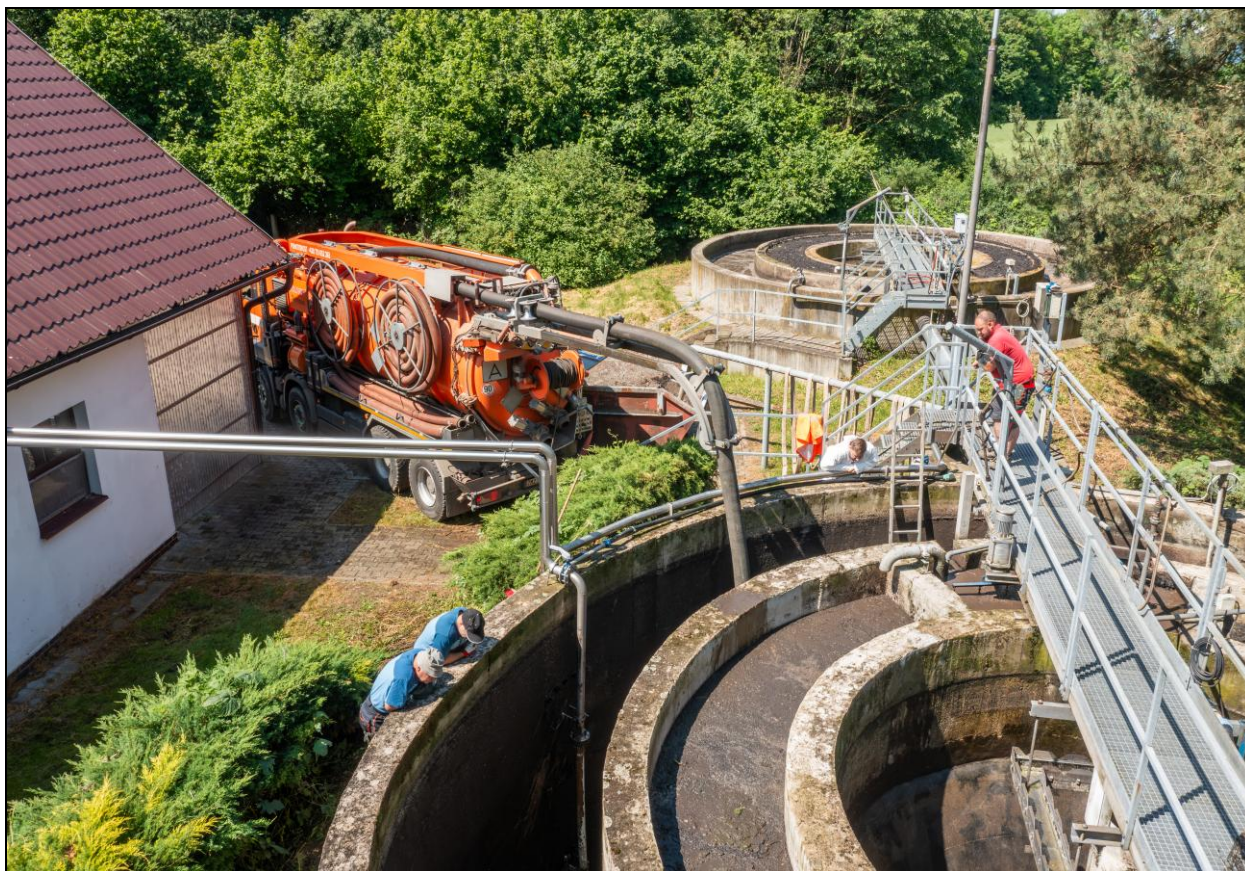
Čištění nádrží na ČOV Dlouhá Loučka z důvodu následné instalace nových míchadel (květen 2024)
