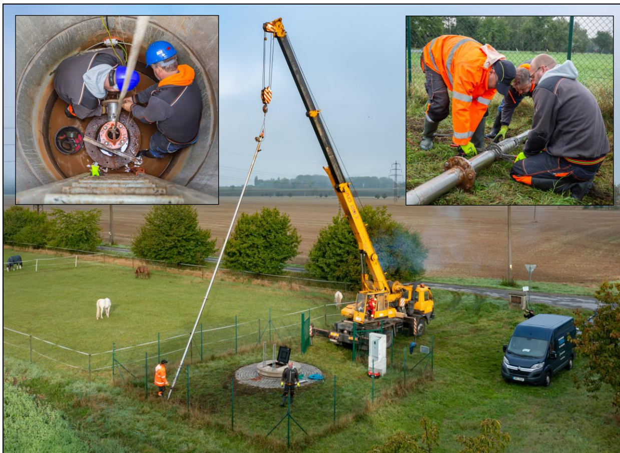
Výměna čerpadla ve vodním zdroji Bohuňovice – Skupinový vodovod Bohuňovice (srpen 2024)
