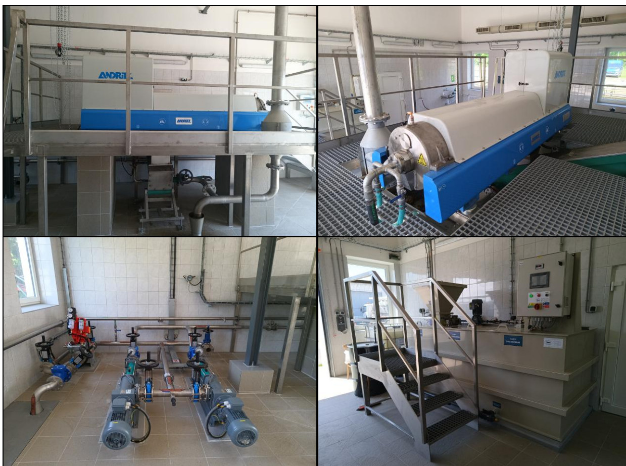
ČOV Šternberk – nová odstředivka k odvodnění kalů, nová čerpadla a dávkování flokulantu (květen 2024)
