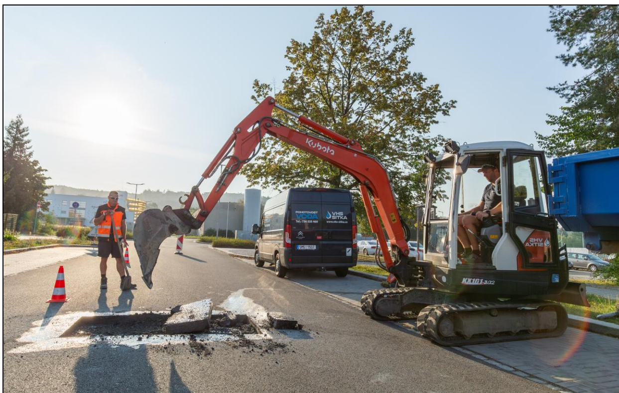
Výměna armatury (uzávěru) před průmyslovým areálem (srpen 2024)
