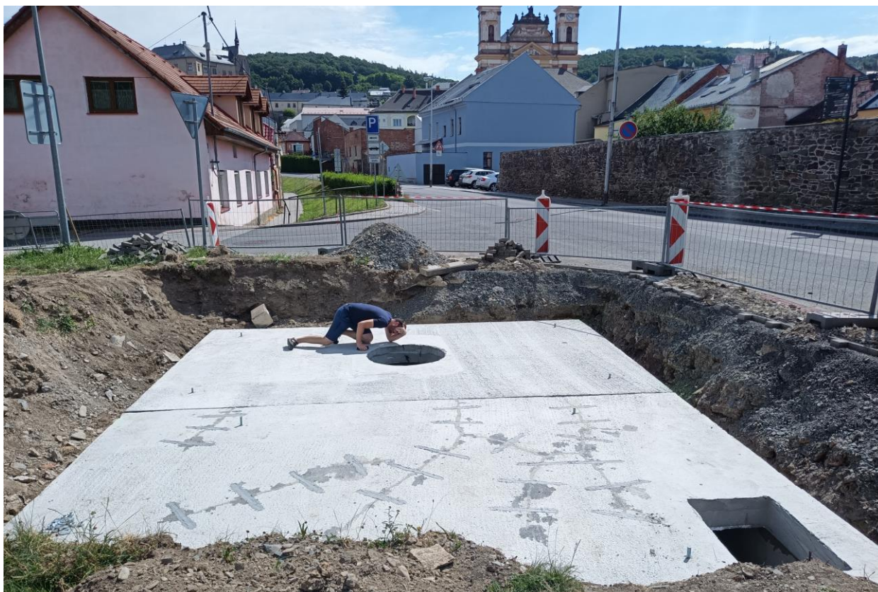
Nový strop odlehčovací komory OK 6A u vodního toku Sitka na ulici Dvorská ve Šternberku (srpen 2022).
