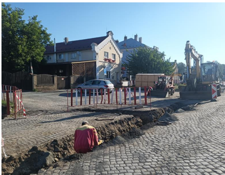
Výměna starého vodovodu v délce 621 m za nový na ulicích Uničovská a Litovelská (srpen / září 2022).
