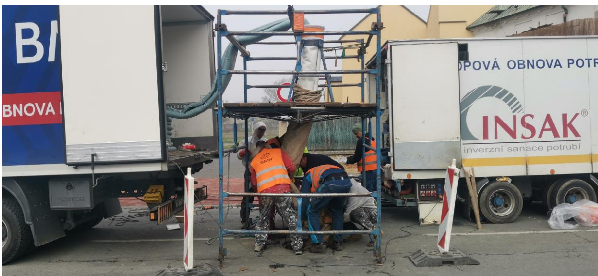
Bezvýkopové opravy kanalizačního potrubí metodou vložkování na náměstí Svobody (listopad 2022).
