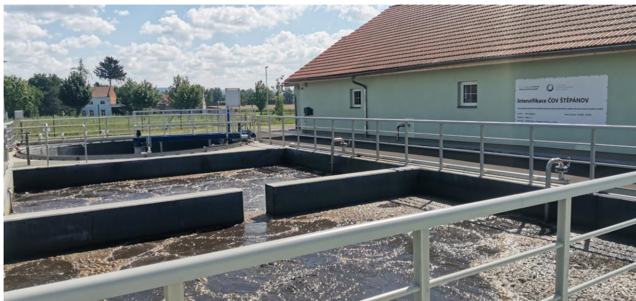
Dokončená intenzifikace ČOV Štěpánov – investor Město Štěpánov (nové venkovní objekty, srpen 2022).
