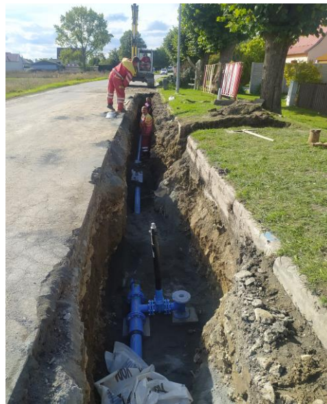
Výměna starého vodovodu v délce 621 m za nový na ulicích Uničovská a Litovelská (srpen / září 2022).
