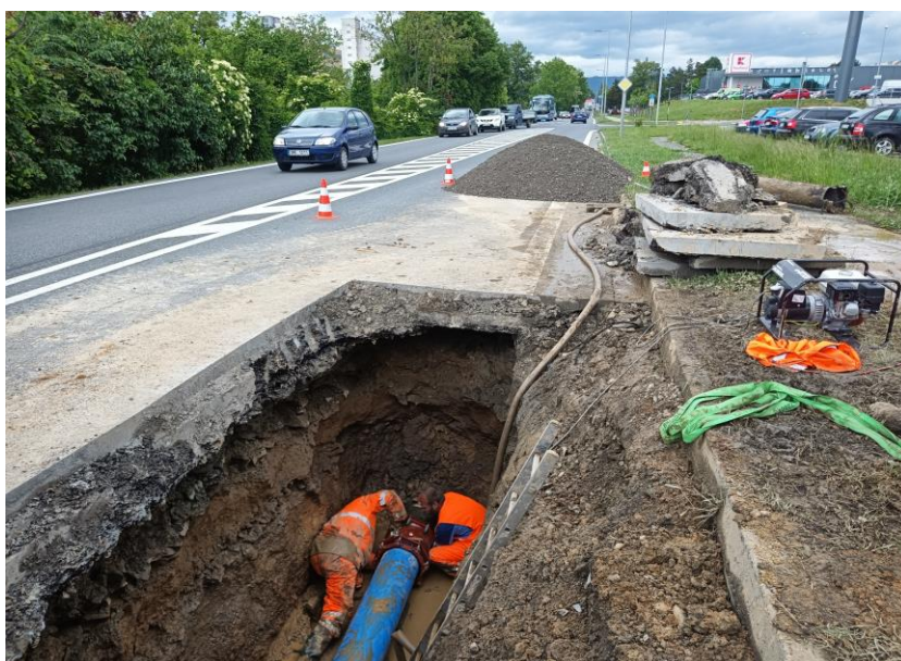
Odstraňování havárie na vodovodním přívaděči na ul. Olomoucká ve Šternberku (červen 2022).
