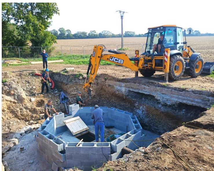
Výměna starého vodovodu v délce 621 m za nový na ulicích Uničovská a Litovelská (srpen / září 2022).
