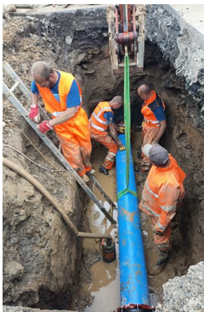
Odstraňování havárie na vodovodním přívaděči na ul. Olomoucká ve Šternberku (červen 2022).
