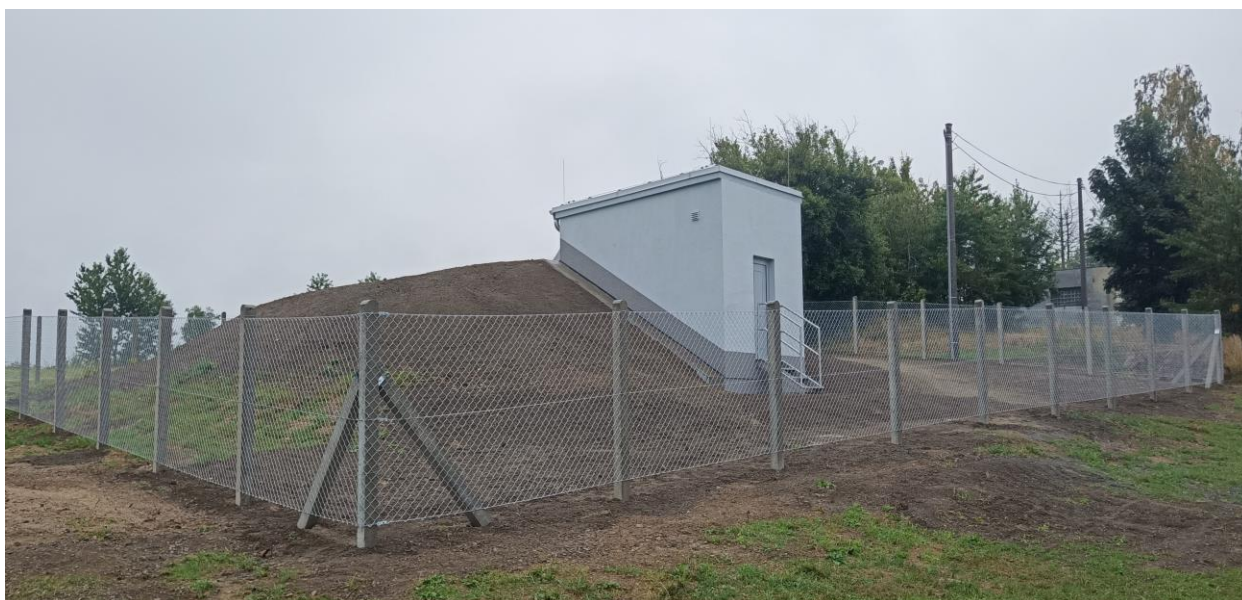
Pohled na vodojem Dalov po rekonstrukci (srpen 2021)
