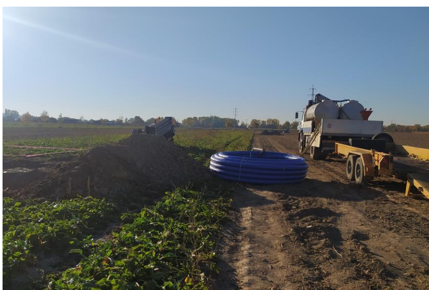
Pokládání příváděcího vodovodního řadu pro obec Lužice metodou berstliningu (říjen 2021).
