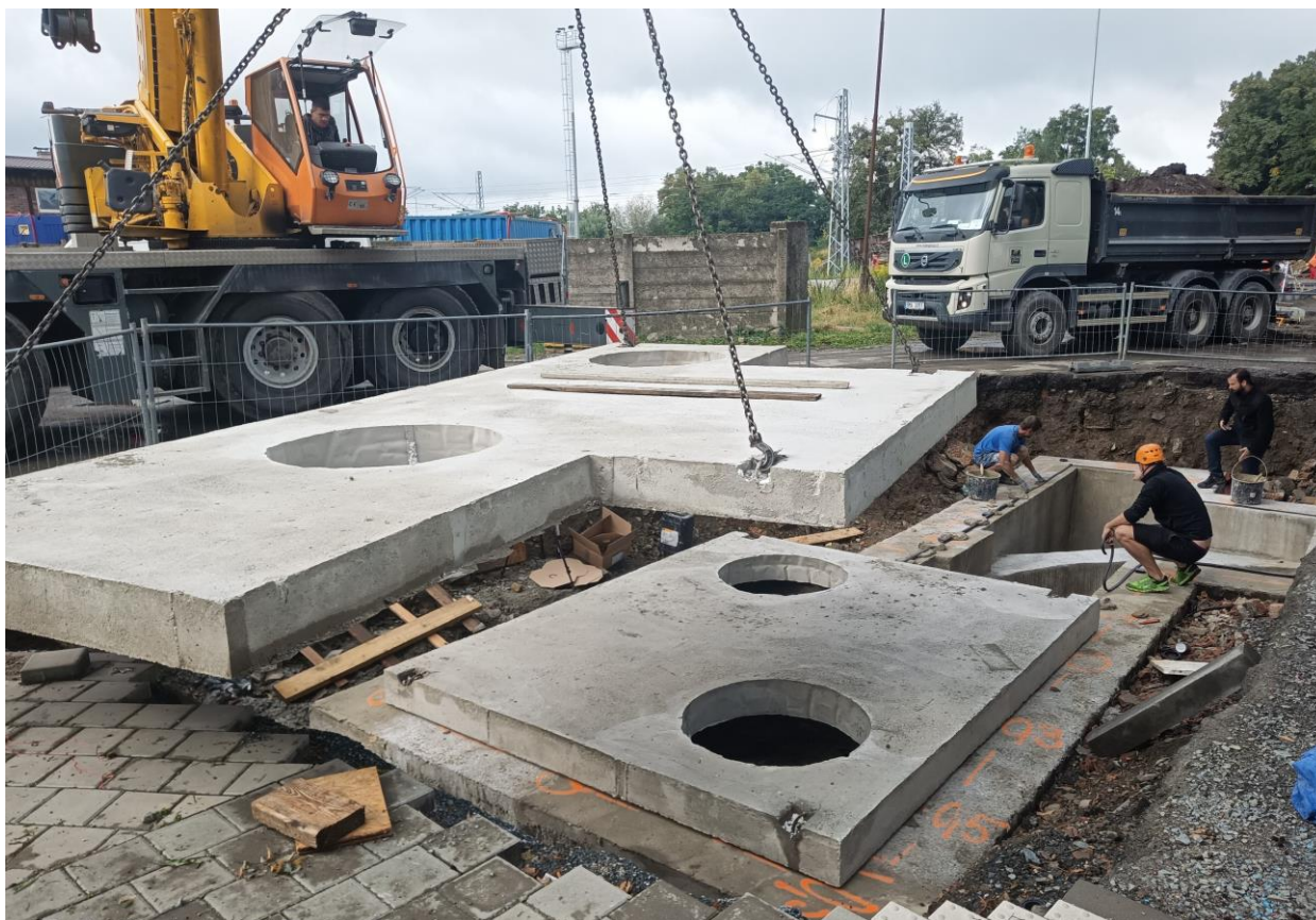
Pokládání betonových dílů stropu odlehčovací komory OK 2A na ulici Pískoviště (srpen 2021).
