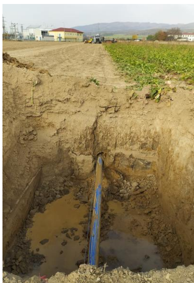
Pokládání příváděcího vodovodního řadu pro obec Lužice metodou berstliningu (říjen 2021).
