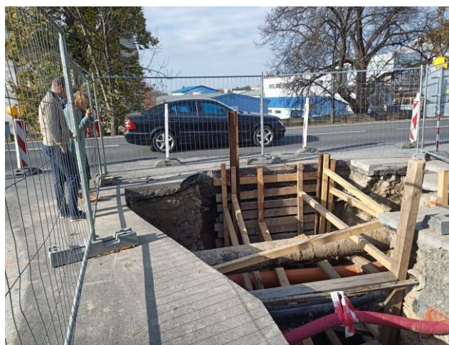
Vkládání potrubí do ocelové chráničky protlačené pod ulicí Olomoucká – pohled z areálu společnosti Eutech a ze začátku ulice gen. Eliáše (listopad 2021).
