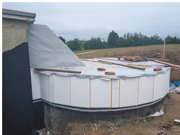
Zateplování akumulční nádrže (červen 2021)
