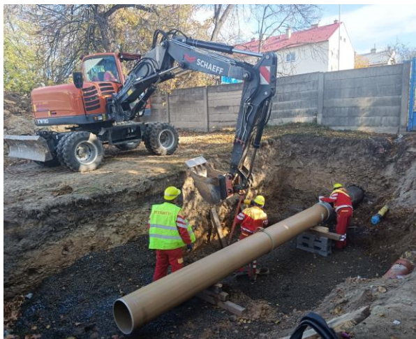
Vkládání potrubí do ocelové chráničky protlačené pod ulicí Olomoucká – pohled z areálu společnosti Eutech a ze začátku ulice gen. Eliáše (listopad 2021).
