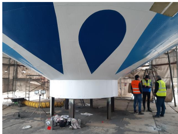
Založení vodojemu a montáž akumulační nádrže, Moravská Huzová (listopad / prosinec 2020)
