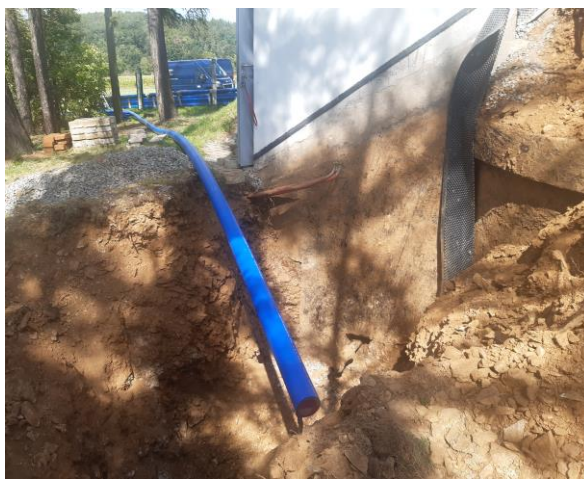
Napojení přivaděče na vodojem Babice-Lužice
