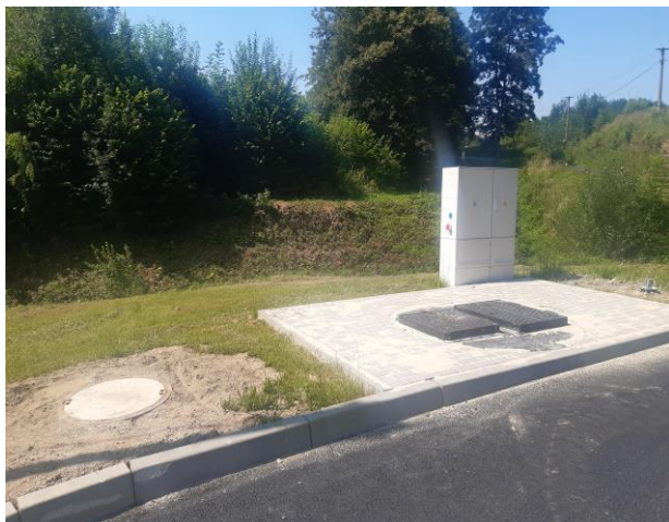
Čerpací stanice č. 2 po dokončení (srpen 2020)
