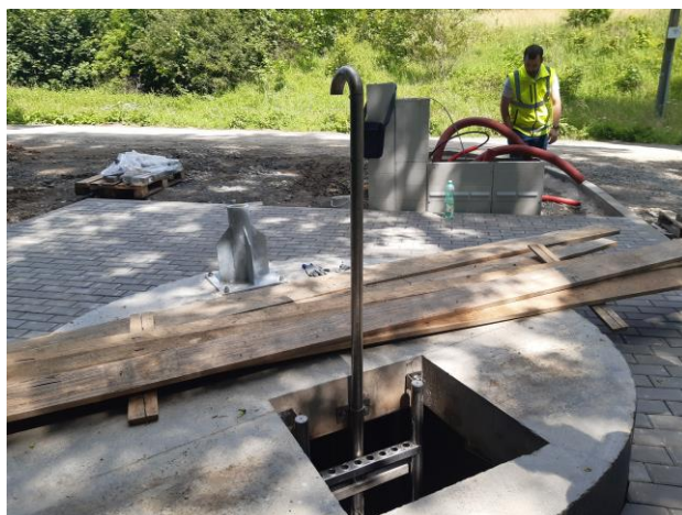
Stavba čerpací stanice č. 1 (červen 2020)
