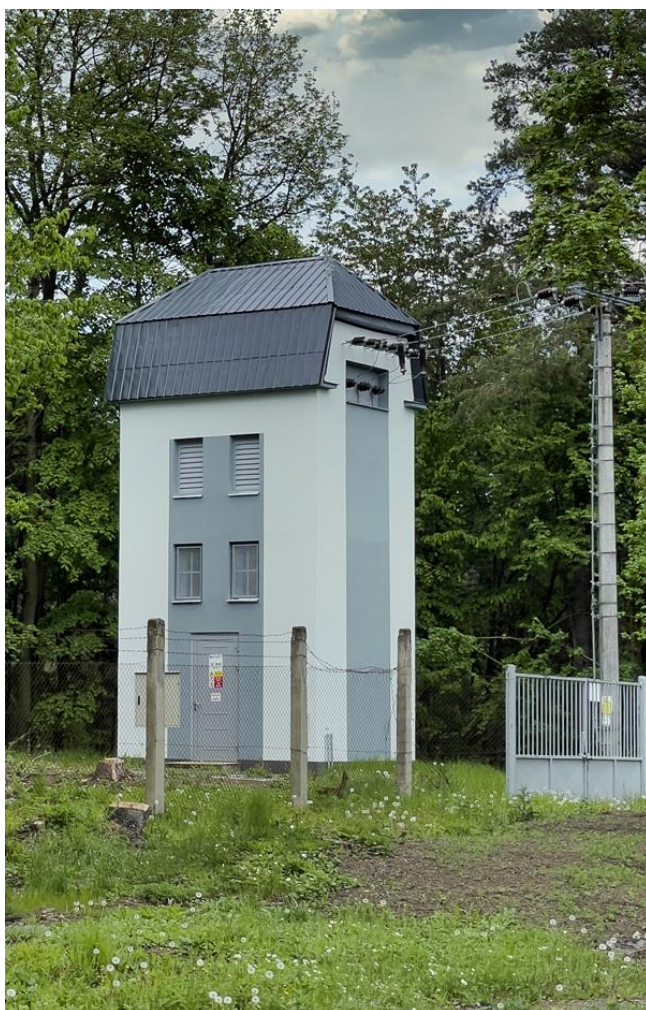
Opravená trafostanice Krakoviče
