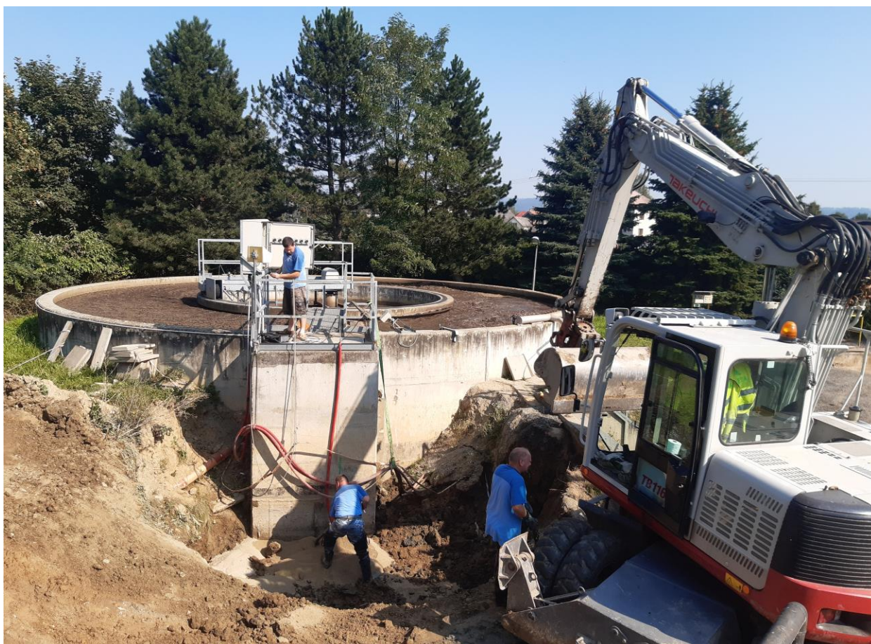
ČOV Šumvald – práce na opravách (září 2020)
