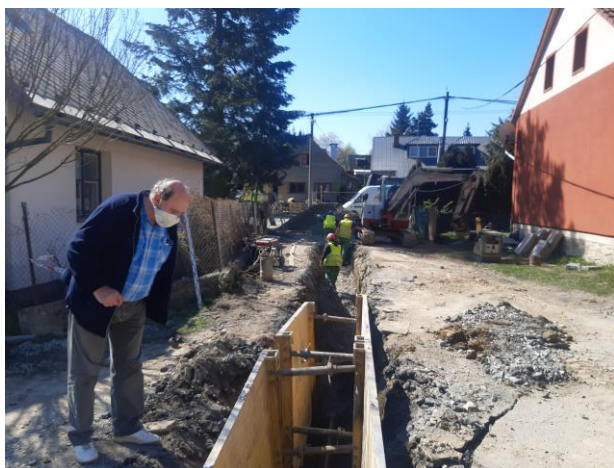
Výkop pro potrubí ve středu obce (duben 2020)
