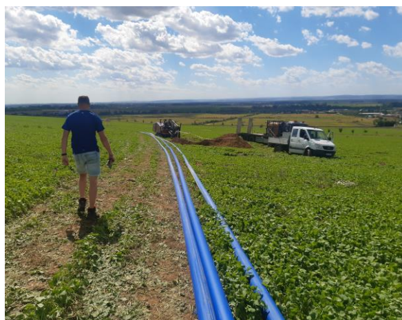
Oprava přivaděče do Lužic (srpen 2020)
