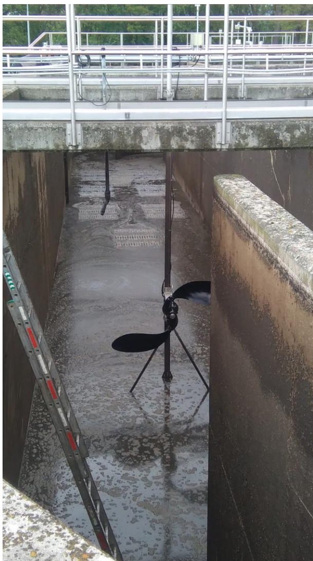
Výměna aeračních elementů v aktivaci ČOV Šternberk.
