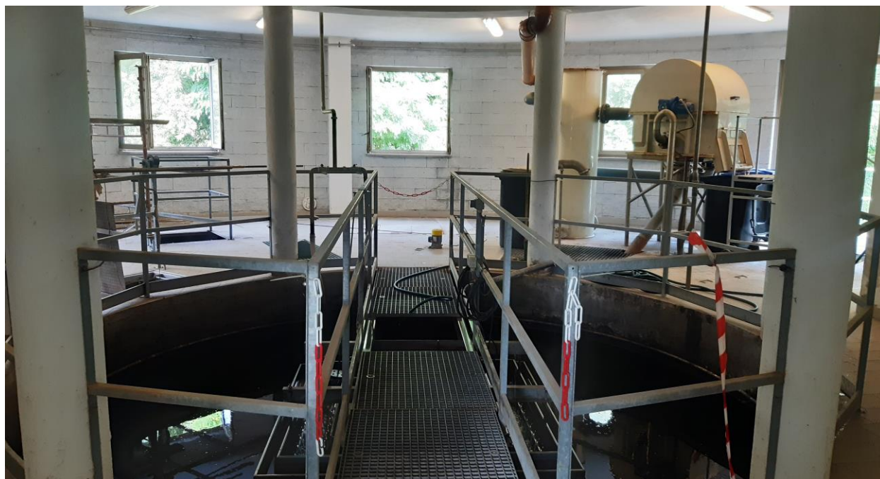
ČOV Újezd – pozvolný průběh prací na zkapacitnění linky (červenec 2019).
