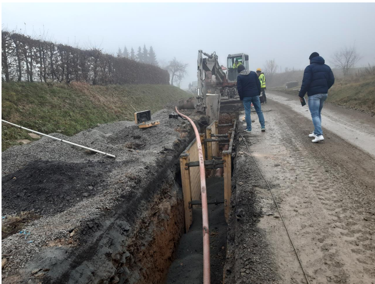
Chabičov – pokládka výtlačku v horní části obce (listopad 2019).
