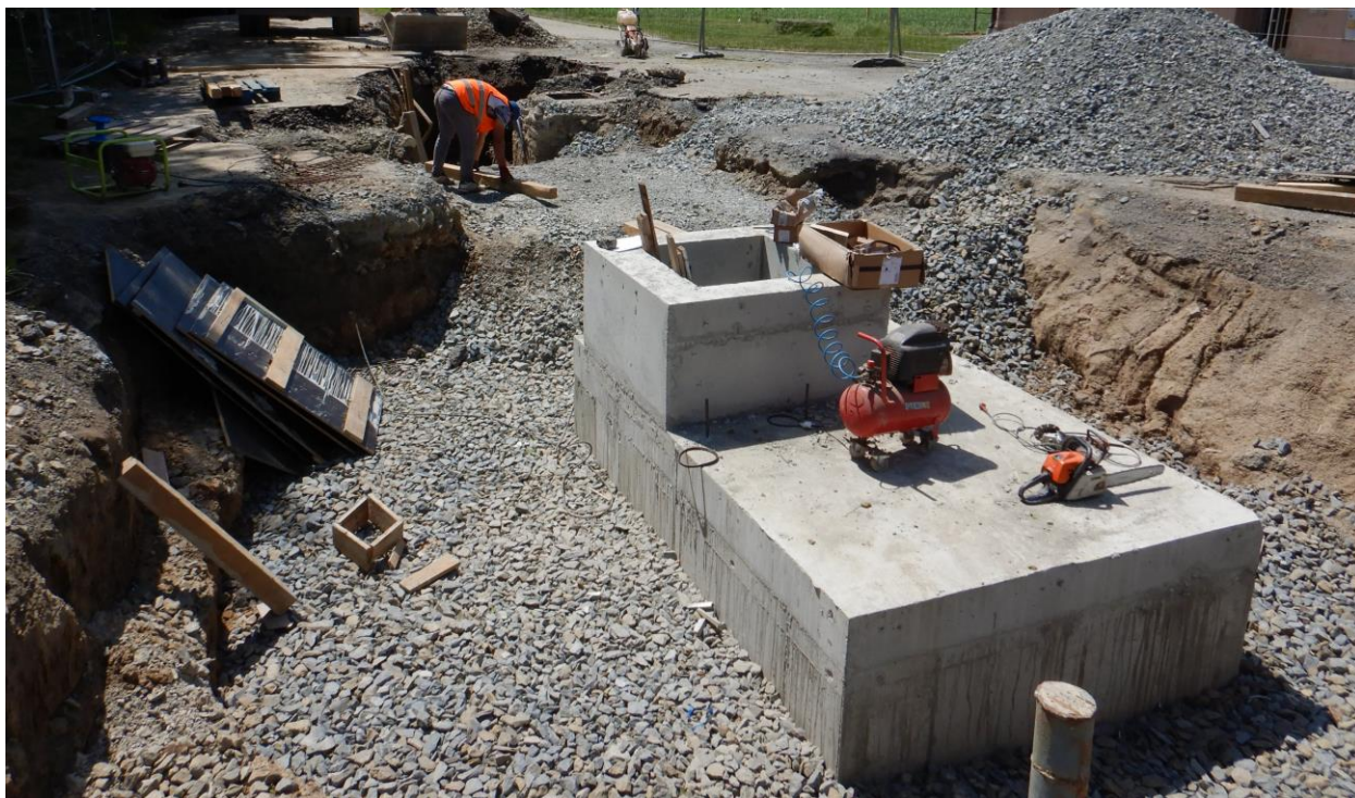
Realizace přeložky vodovodu v Mladějovicích u železničního přejezdu (červen 2019).
