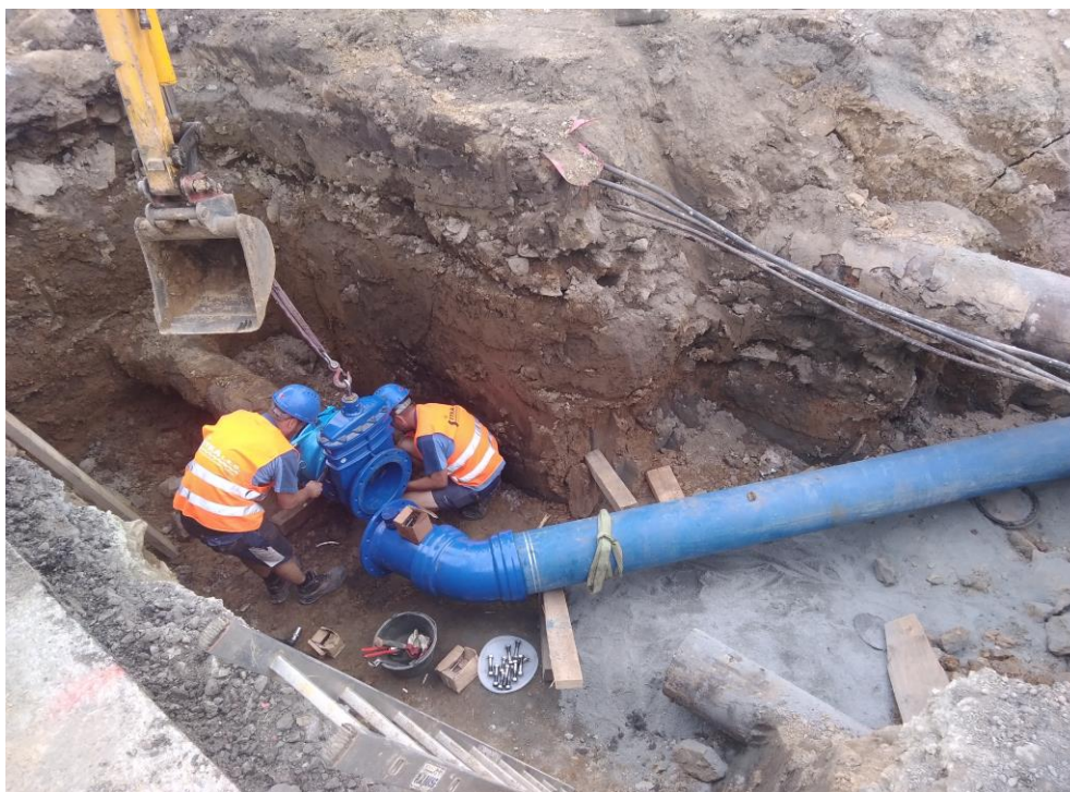
Realizace přeložky vodovodu pod křižovatkou ulic Olomoucká a Lhotská ve Šternberku (červen 2018)
