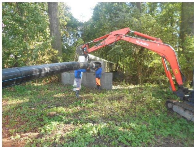
Stavba nového vodovodu v ul. Nad Nemocnicí
